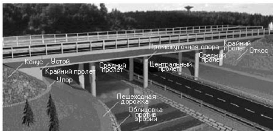
Рисунок 7. Опоры мостового сооружения и подходы к мосту.
