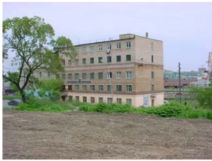
Рис. 5.18. Здание товарной станции (два верхних этажа надстроены по результатам экспериментальных измерений)
