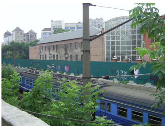
Рис. 5.27. Учебный корпус (строение № 2) ДВГТУ (вид со стороны железной дороги)
